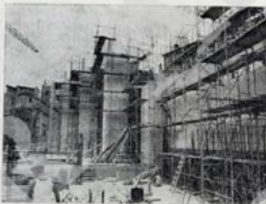
Crescono le strutture del palazzetto dello sport a S. Biagio di Castello
