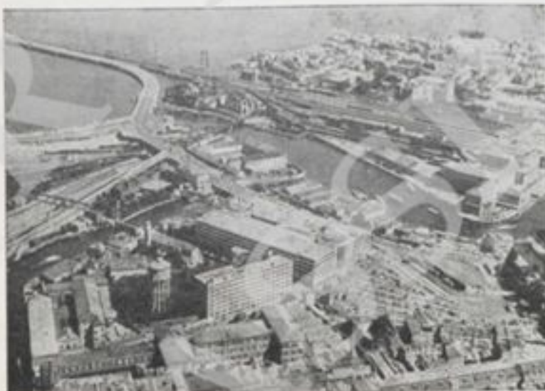
IL TERMINAL DI PIAZZALE ROMA VERSO IL PONTE
