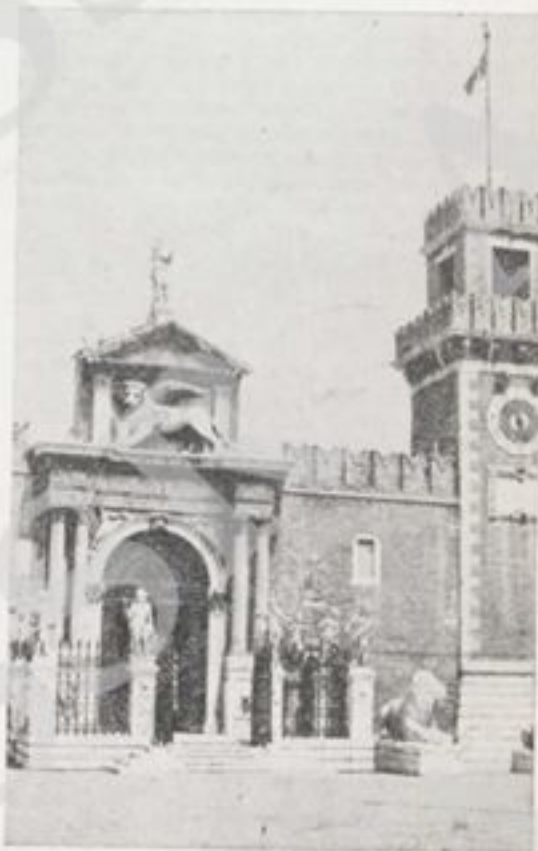
LA PORTA MONUMENTALE DELL'ARSENALE RESTAURATA DALLA « DANTE ALIGHIERI »
