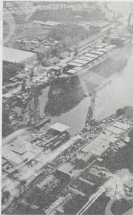
IL CANTIERE BRED A DI MARGHERA
