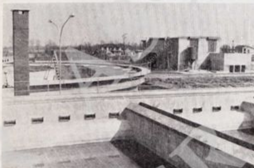
QUASI PRONTO IL POTABILIZZATORE DI CA' SOLARO
