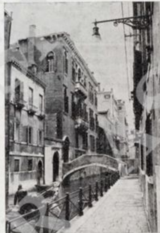
IN CORSO L'INDAGINE SULLA PROPRIETA' IMMOBILIARE
