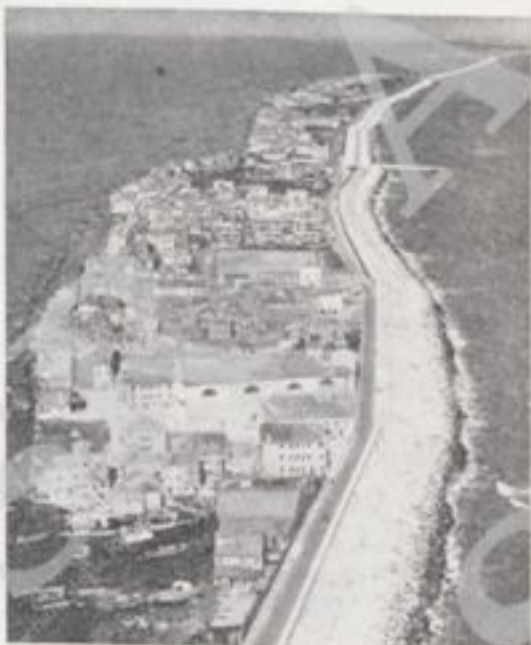
Gli abitati dell'isola di Pellestrina (il centro si vede in primo piano) che sorgono sullo stretto litorale tra laguna e mare, cui si contrappongono i ricostruiti « murazzi » (a destra).
