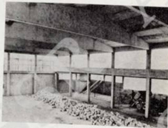
A SINISTRA E SOPRA: LA SCUOLA ELEMENTARE DI CATENE (16 AULE CON ANNESSA PALESTRA)
