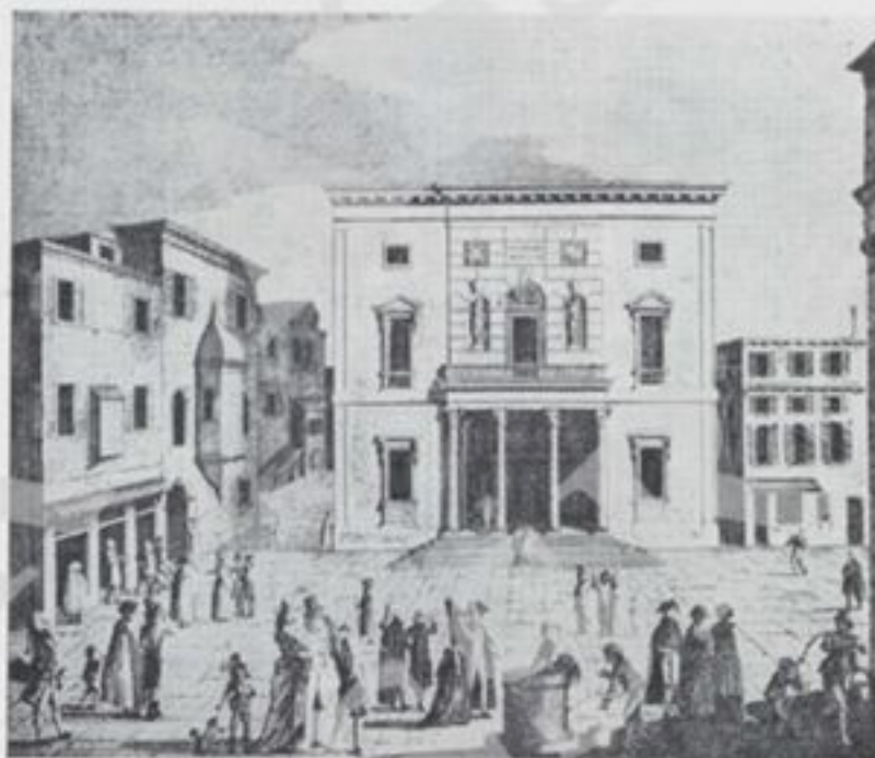
La facciata del Teatro La Fenice (in una stampa settecentesca)
