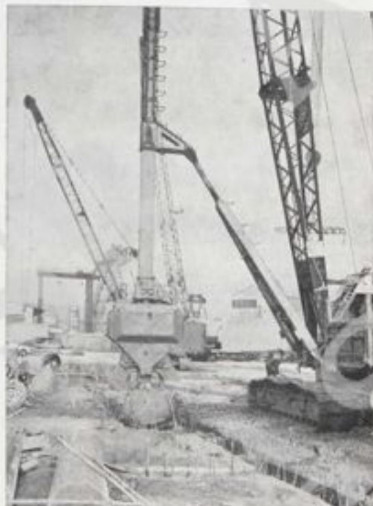
I lavori in corso alla banchina « Emilia »
