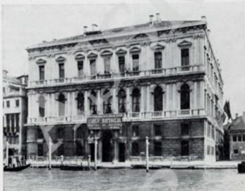
Palazzo Grassi: a San Samuele uno degli edifici più famosi sul Canal Grande (splendida dimora patrizia del '700)
