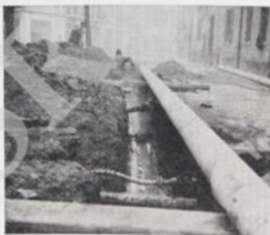
Una veduta dei lavori per la costruzione delle fognature sperimentali a Cannaregio nord.
