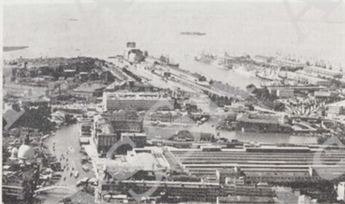
IL COMPLESSO DEI TERMINALI FERROVIARIO (S. LUCIA), STRADALE (PIAZZALE ROMA - TRONCHETTO) E PORTUALE (MARIITIMA)
