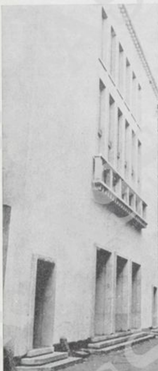
LA NUOVA FACCIATA DEL TEATRO COME APPARE PRIMA DELLE RIFINITURE E (NELLA PAGINA ACCANTO) PARTICOLARI DEGLI INTERNI A LAVORI IN CORSO
