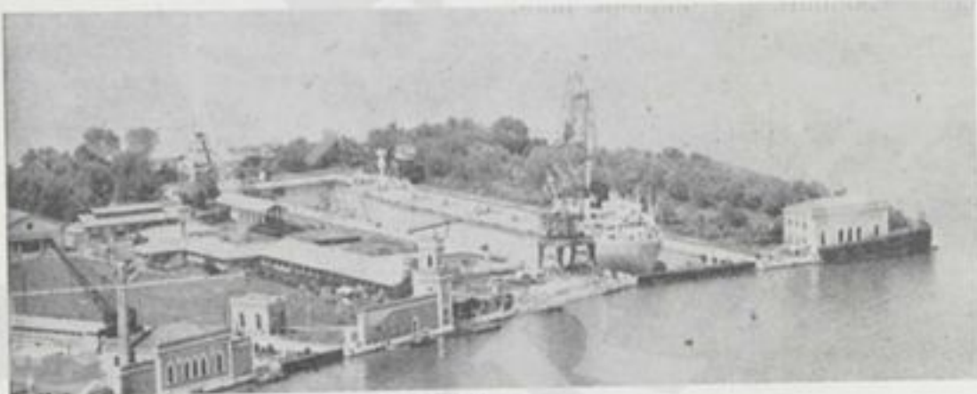
L'AREA CANTIERISTICA A NORD-EST DELL'ARSENALE
