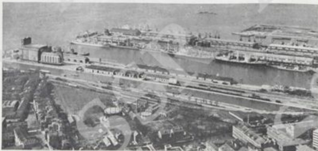
Le banchine e gli impianti portuali di Marghera
