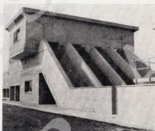
SOLLEVAMENTO DELL'ACQUA GREZZA MEDIANTE POMPE A VITE DI ARCHIMEDE
