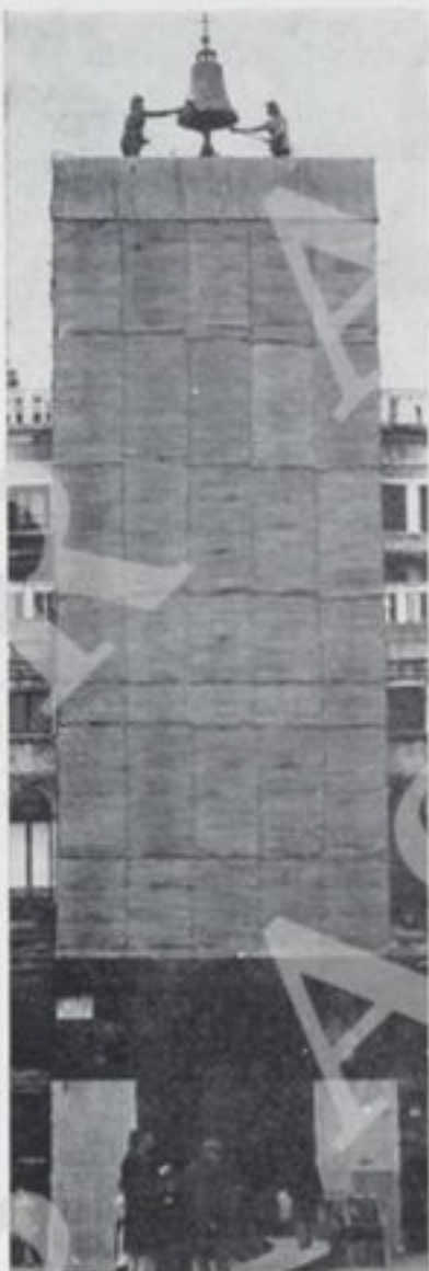
La torre dell'orologio coperta dalle impalcature erette per consentire gli interventi di pulitura e restauro promossi dal Rotary Club veneziano
