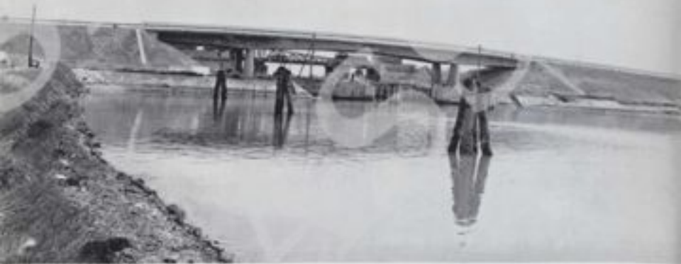
Compressorio Sud. Nuovo ponte sulla conca grande di Ronchi, nella vallata della provinciale Venezia-Padova.
