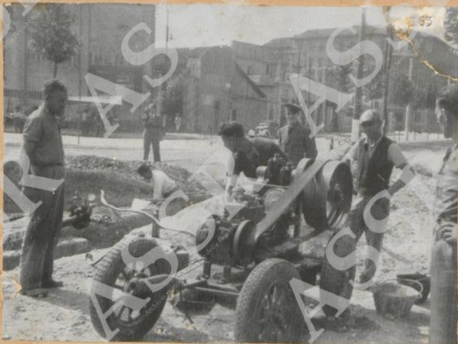
Metanodotto della Via Emilia - Prove idrauliche alla pressione di 100 atmosfere - pressione di esercizio 60 - 40 atmosfere -
