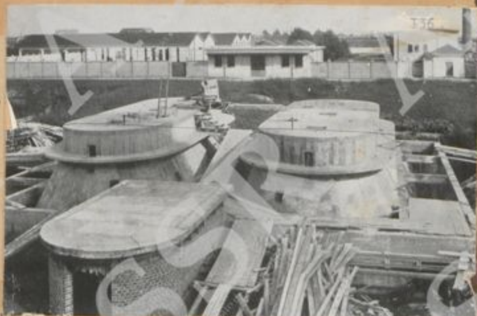
Metano biologico costruzione dell'impianto per la utilizzazione dei rifiuti del Macello pubblico di Milano - Consorzio Macellatori
