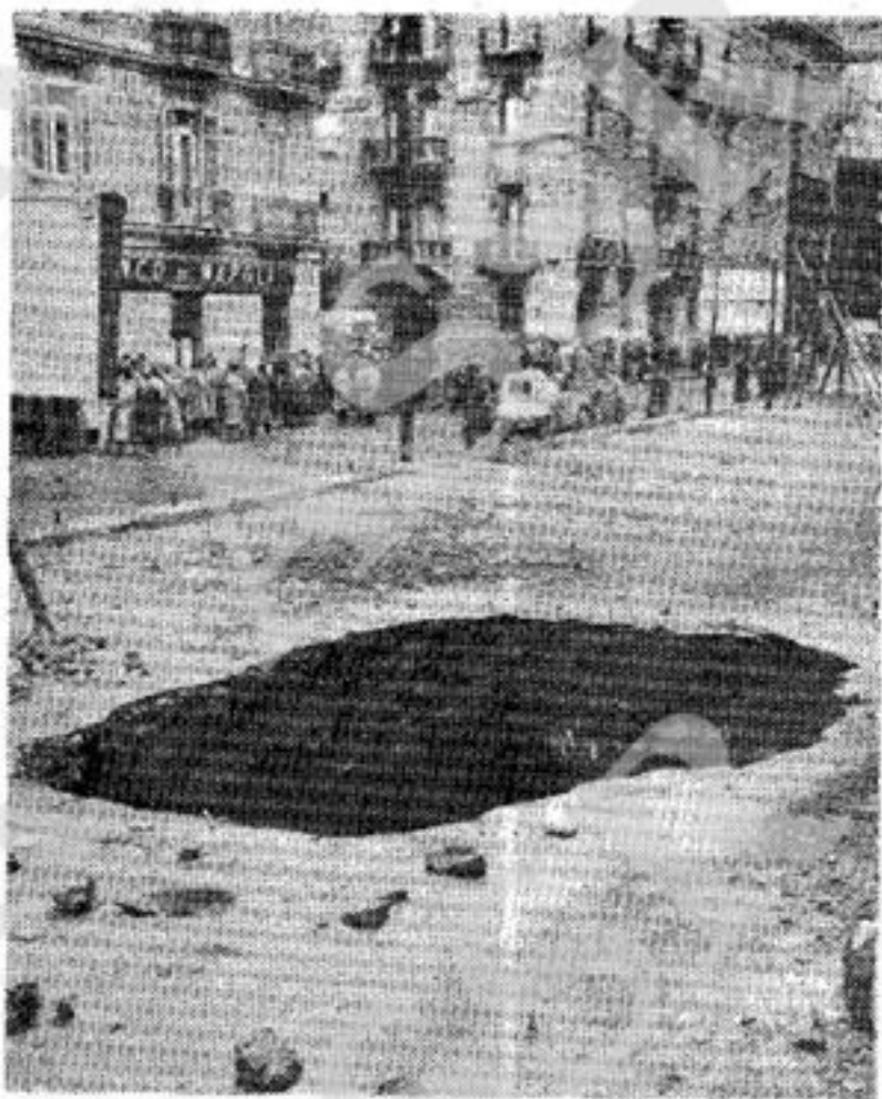
Una voragine a Corso Novara: nell'inverno '54 decine di queste voragini si aprono nelle vie sconquassate di Napoli
