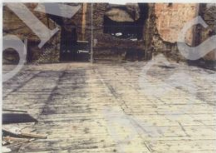
UNA PORZIONE DEL PALCOSCUENICO ANCORA PARZIALMENTE INGOMBRATO DA MATERIALI DI SCENA IL CUI IMPALCATO RISULTA COMPLETAMENTE STACCATO DAI MURI D'AMBITO (1,2,3). PARTICOLARI DI ALCUNE TORRI METALLICHE CHE SI ELEVANO DAL PALCOSCUENICO (4,5,6)
