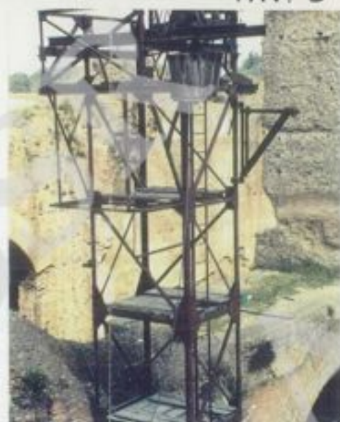
UNA PORZIONE DEL PALCOSCUENICO ANCORA PARZIALMENTE INGOMBRATO DA MATERIALI DI SCENA IL CUI IMPALCATO RISULTA COMPLETAMENTE STACCATO DAI MURI D'AMBITO (1,2,3). PARTICOLARI DI ALCUNE TORRI METALLICHE CHE SI ELEVANO DAL PALCOSCUENICO (4,5,6)
