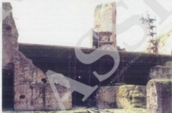
UNA VEDUTA PANORAMICA DELLA STRUTTURA RETICOLARE DEL PALCOSCUENNO (1) ED IL SUO PROSPETTO POSTERIORE (2). I MONTANTI POGGIANO SU BASI DI CONGLOMERATO CEMENTIZIO REALIZZATE, SALVO ALCUNE ECCEZIONI, SU MURATURE MODERNE (3, 4).
