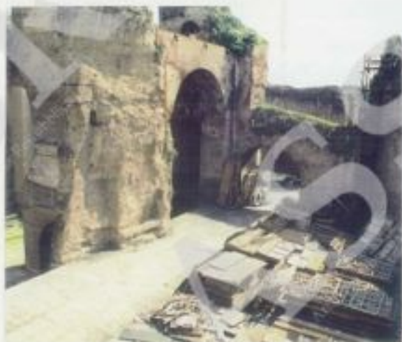
UNA PORZIONE DEL PALCOSCUENICO ANCORA PARZIALMENTE INGOMBERO DA MATERIALI DI SCENA IL CUI IMPALCATO RISULTA COMPLETAMENTE STACCATO DAI MURI D'AMBITO (1,2,3). PARTICOLARI DI ALCUNE TORRI METALLICHE CHE SI ELEVANO DAL PALCOSCUENICO (4,5,6)
