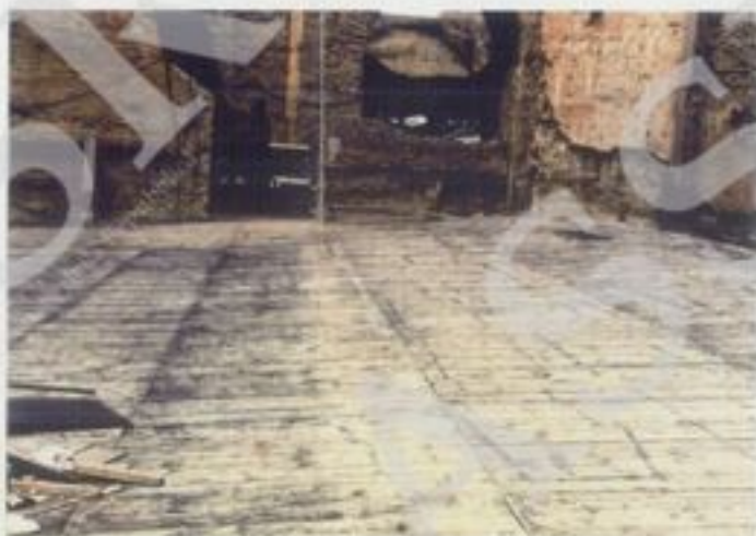
UNA PORZIONE DEL PALCOSCUENICO ANCORA PARZIALMENTE INGOMBERO DA MATERIALI DI SCENA IL CUI IMPALCATO RISULTA COMPLETAMENTE STACCATO DAI MURI D'AMBITO (1,2,3). PARTICOLARI DI ALCUNE TORRI METALLICHE CHE SI ELEVANO DAL PALCOSCUENICO (4,5,6)
