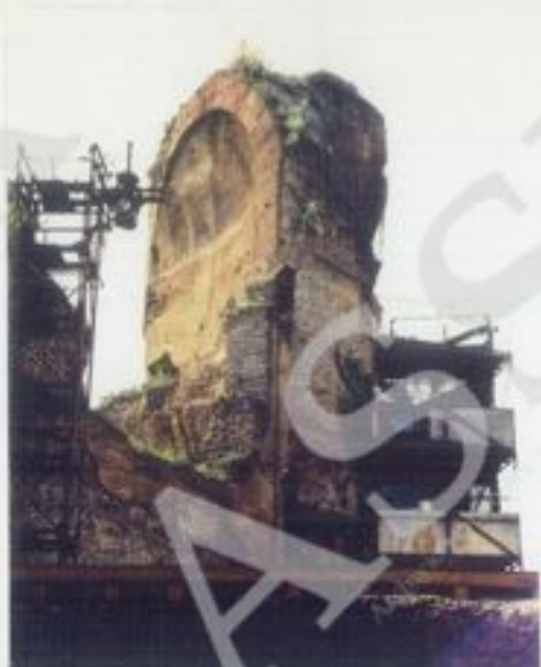
UNA PORZIONE DEL PALCOSCUENICO ANCORA PARZIALMENTE INGOMBERO DA MATERIALI DI SCENA IL CUI IMPALCATO RISULTA COMPLETAMENTE STACCATO DAI MURI D'AMBITO (1,2,3). PARTICOLARI DI ALCUNE TORRI METALLICHE CHE SI ELEVANO DAL PALCOSCUENICO (4,5,6)
