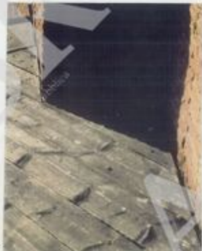
UNA PORZIONE DEL PALCOSCUENICO ANCORA PARZIALMENTE INGOMBERO DA MATERIALI DI SCENA IL CUI IMPALCATO RISULTA COMPLETAMENTE STACCATO DAI MURI D'AMBITO (1,2,3). PARTICOLARI DI ALCUNE TORRI METALLICHE CHE SI ELEVANO DAL PALCOSCUENICO (4,5,6)
