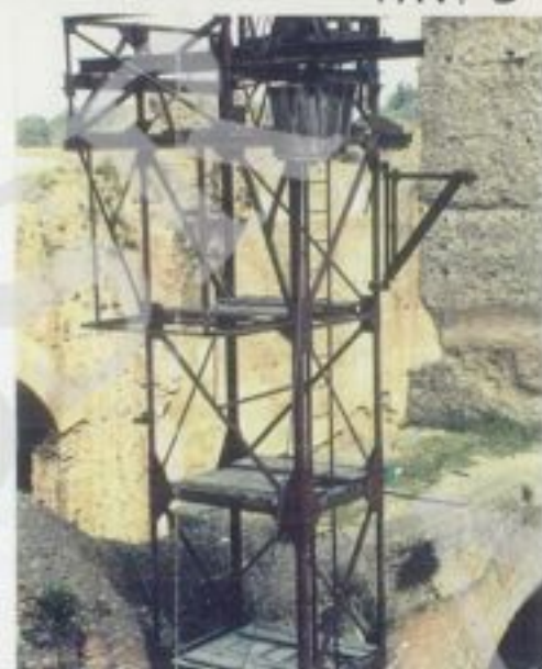
UNA PORZIONE DEL PALCOSCUENICO ANCORA PARZIALMENTE INGOMBERO DA MATERIALI DI SCENA IL CUI IMPALCATO RISULTA COMPLETAMENTE STACCATO DAI MURI D'AMBITO (1,2,3). PARTICOLARI DI ALCUNE TORRI METALLICHE CHE SI ELEVANO DAL PALCOSCUENICO (4,5,6)
