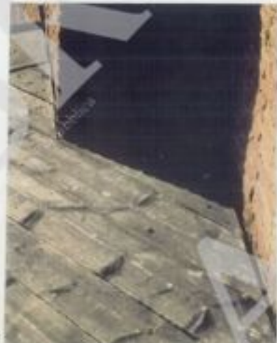
UNA PORZIONE DEL PALCOSCUENICO ANCORA PARZIALMENTE INGOMBRATO DA MATERIALI DI SCENA IL CUI IMPALCATO RISULTA COMPLETAMENTE STACCATO DAI MURI D'AMBITO (1,2,3). PARTICOLARI DI ALCUNE TORRI METALLICHE CHE SI ELEVANO DAL PALCOSCUENICO (4,5,6)
