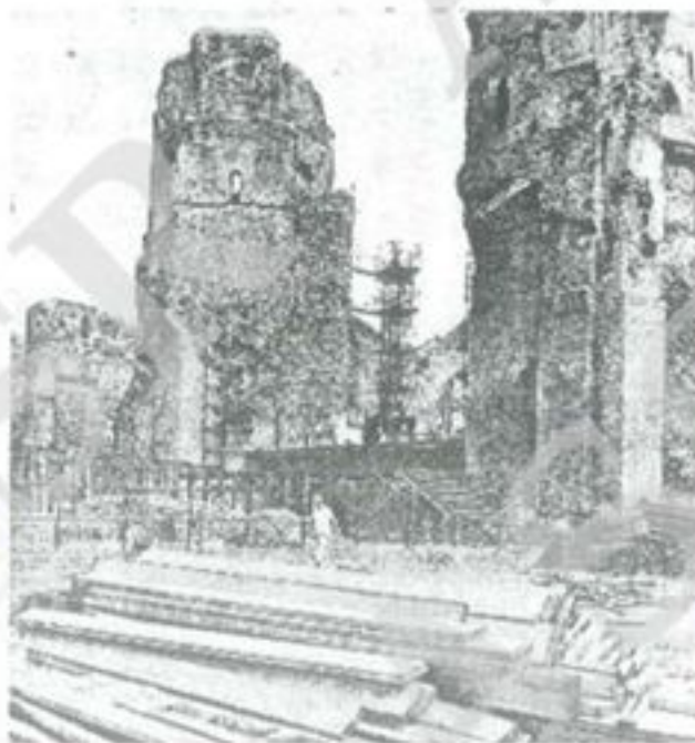
L'Opera è stata «sfrattata» dalle Terme di Caracalla
