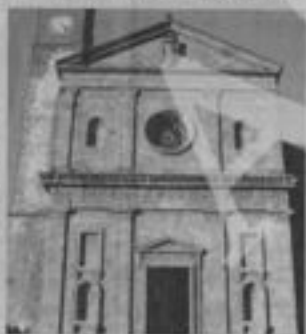
La facciata di San Biagio a Caldana
