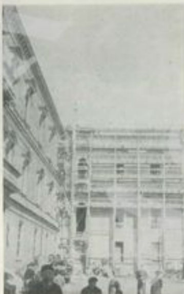
L'ala, a destra del prospetto, in costruzione (1962)
