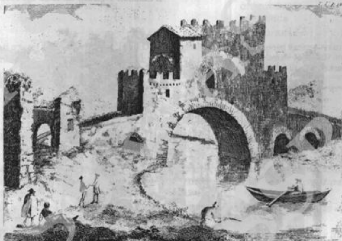
Ponte Nomentano, sulla Via Nomentana, nell'Aniene che moltiplica i corsi di Porto Flaminio.
