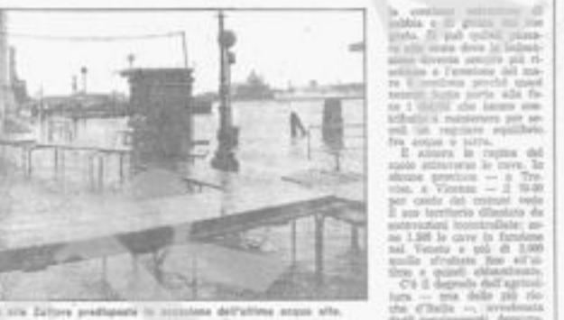
VENEZIA - Passerella sul canale preparata in occasione dell'ultima acqua alta.
