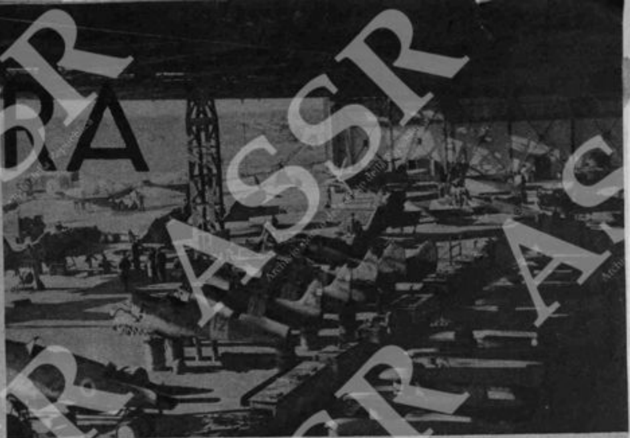
L'officina di una squadra di riparazioni aeronautiche. Il tenace lavoro dei nostri specialisti ha reso possibile perfino la costruzione di nuovi velivoli con rottami di aerei abbandonati su aeroporti dell'Italia meridionale, Sicilia e Africa
